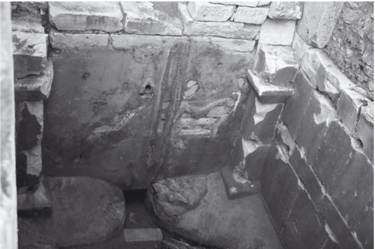
Abb. 845: EN1, nördl. Abschlusswand der Zisterne mit Zulauf, Ablauf u. Reinigungsöffnung
