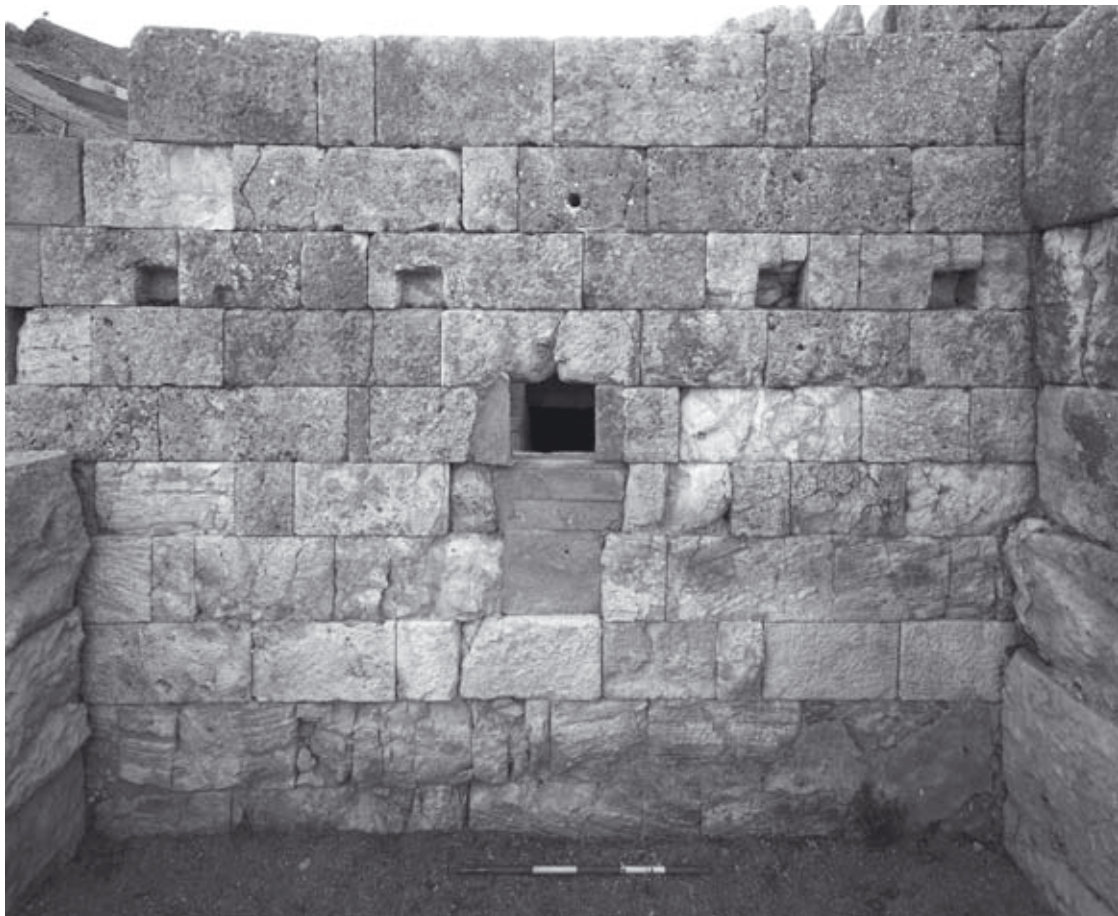
Abb. 839 Bühnengebäude: sekundäre Balkenlöcher an der hell. Westmauer
