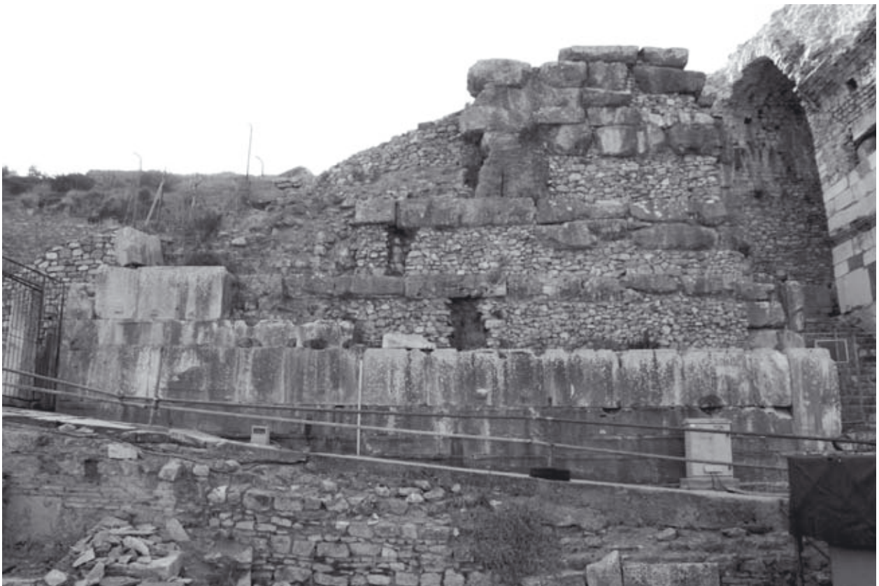
Abb. 813: Süd-Analemma, nördl. Fassadenabschnitt. Wandaufbau. Die »Mauerplomben« aus Bruchstein sind modern.
