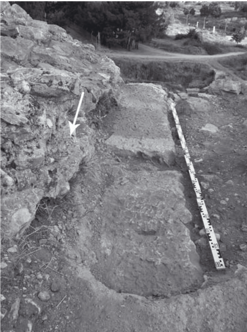
Abb. 823: Unteres Diazoma. Fundamentquader der Diazoma-Wand u. Anschluss des vermutlichen Füllmauerwerks im rückwärtigen Bereich der Quader (Pfeil). Im Hintergrund (l.) moderne Sicherungen der opus caementitium -Oberfläche
