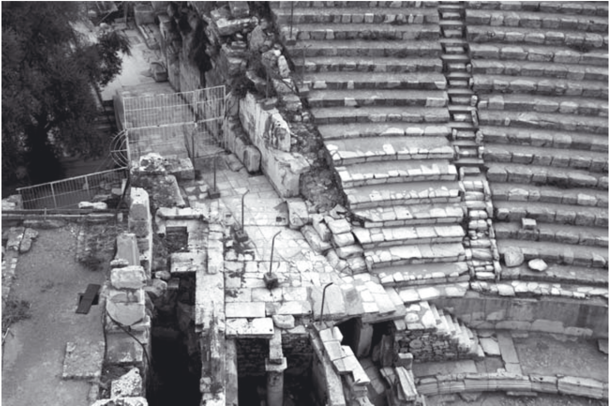
Abb. 794: Plattform oberhalb der N-Parodos. Beginn des (versetzten) nördl. Analemma u. Vorsprung der Fassade
