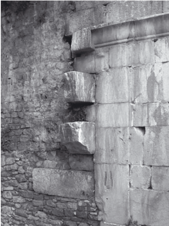
Abb. 808: vomitorium ES1. »Wartesteine« der ehemaligen Schildwand zwischen dem hohen u. niedrigen Gewölbe
