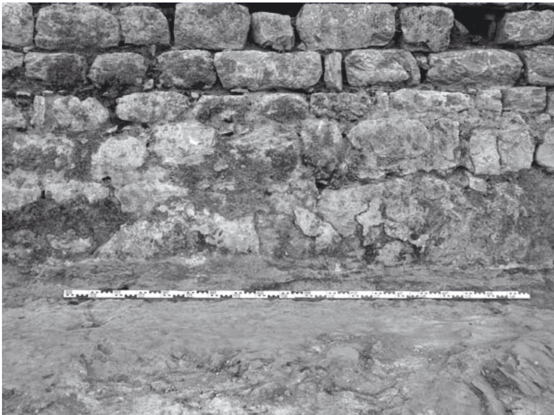
Abb. 834: Portikus. Horizontal abgearbeitete Felsbereiche für die Verlegung des Bodenbelages
