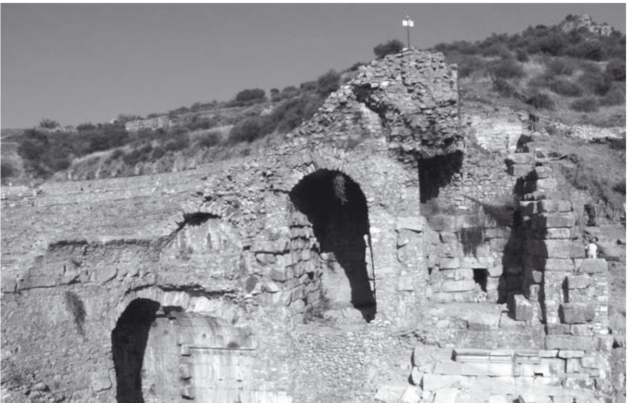
Abb. 807: Südl. Gebäudeflügel. Substruktionskammern u. erh. Bereiche des vomitorium ES1 (Vordergrund)
