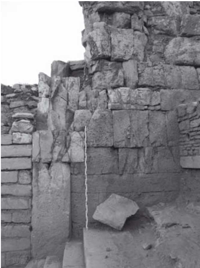
Abb. 810: S-Fassade mit Treppe im Bereich des Zugangs ES1 (l., sekundär verschlossen). Fassadenquader aus weißem Kalkstein; Laibungsquader u. Sichtoberflächen im vomitorium u. Treppenbelag aus weißem Marmor
