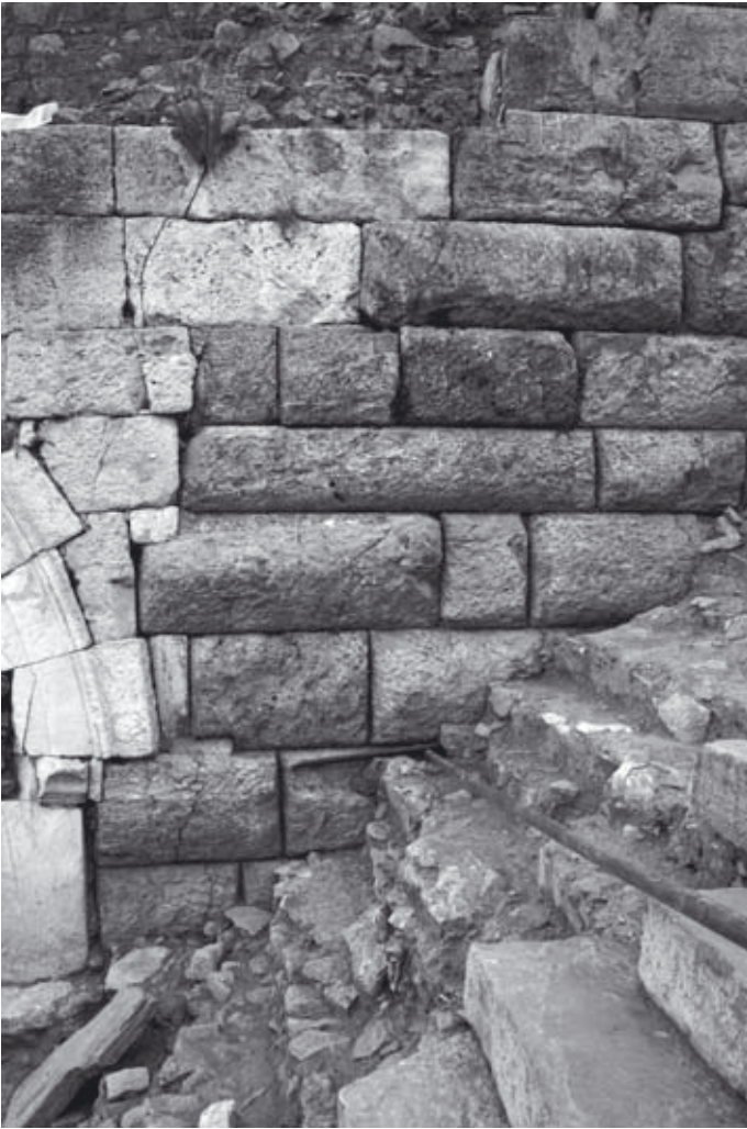
Abb. 804: S-Fassade. Wechsel in der Materialität der Fassade östl. des vomitorium ES2
