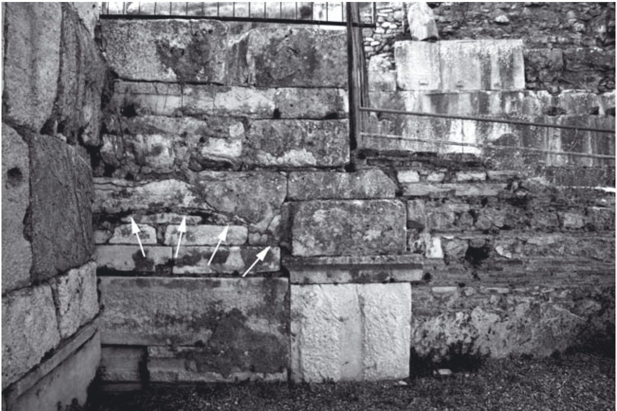
Abb. 786: Süd-Parodos, Zugang von W: südl. Laibungsquader mit Kämpfergesims u. Bogenquader aus Marmor in situ
