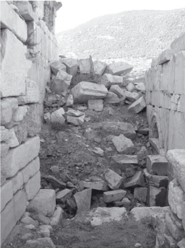
Abb. 840: vomitorium EN1. Vor W-Wand Pfeilerstellung (r.) für das sekundäre Tonnengewölbe
