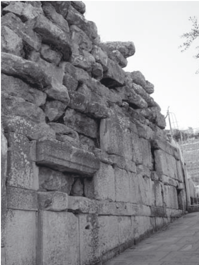
Abb. 795: Nord-Analemma, südl. Fassadenabschnitt, Wandbereich II
