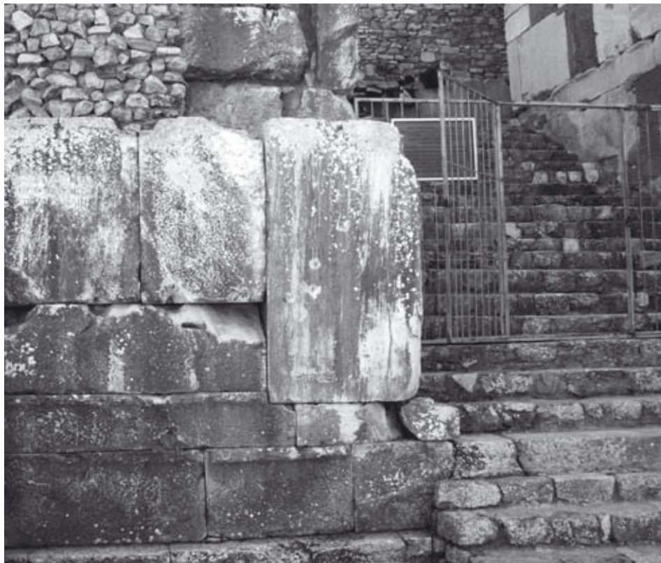
Abb. 815: Süd-Analemma, nördl. Laibung des Zugangs ES1 West. Abarbeitung der Binderlager für Einbau des Eckquaders
