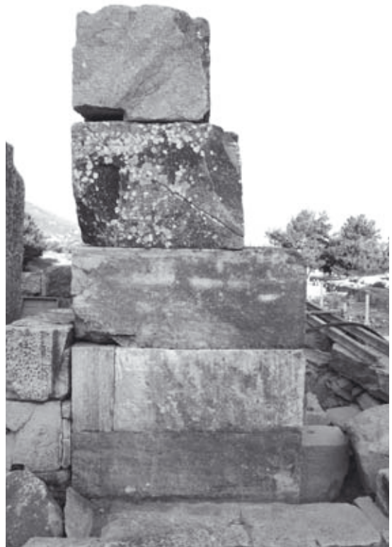
Abb. 755: Bühnengebäude, ›Thyromata-Wand‹ (Phase 2), Pfeiler 1, von O
