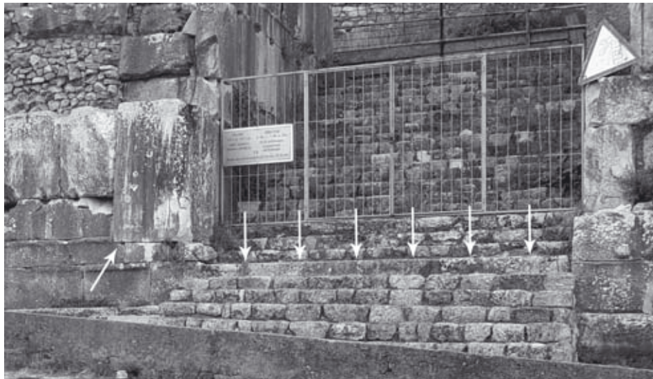
Abb. 814: Süd-Analemma, Zugang ES1 West. Durchgehende Reihe Fassadenquader u. nachträglich eingefügter Eckquader
