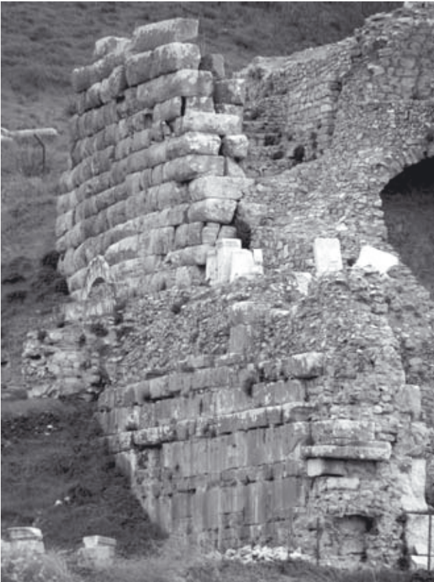
Abb. 842: Nord-Fassade mit der im 4. Jh. n. Chr. vorgelagerten Wandschale (unterer Bereich)
