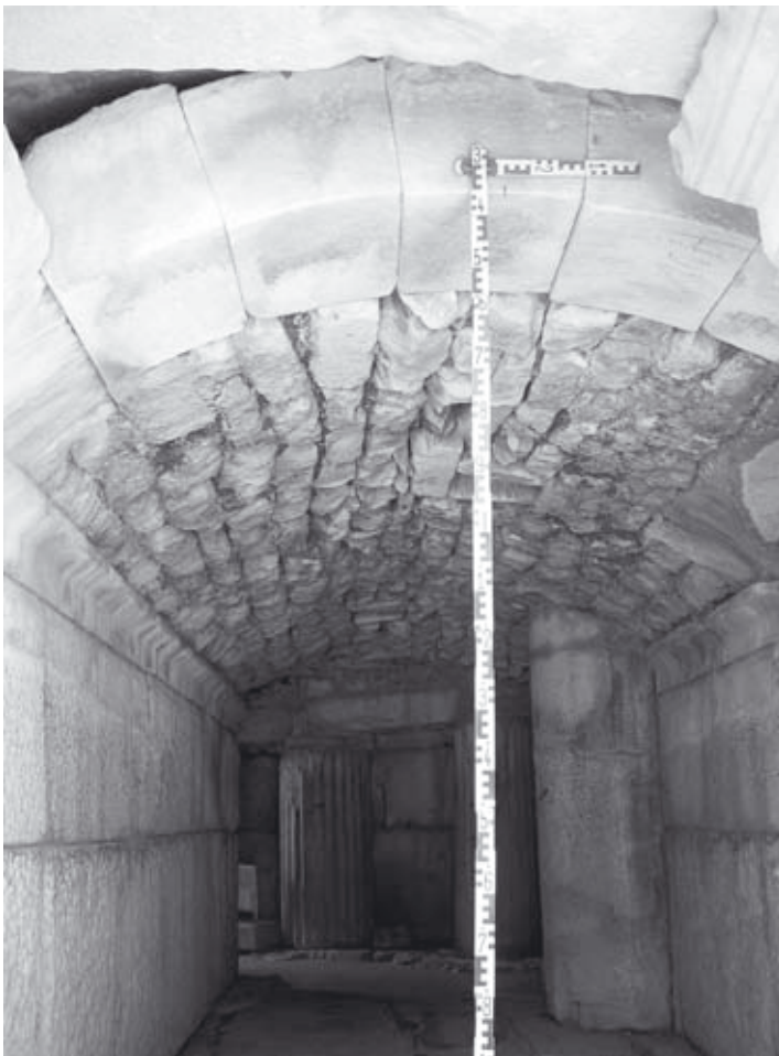
Abb. 785: Blick aus Orchestra in N-Parodos: Wandbauteile u. Kämpfergesims aus Marmor, Gewölbe aus Bruchstein
