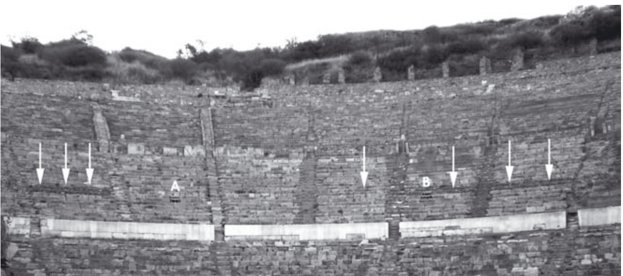
Abb. 824: Auditorium. Der Verlauf der Aristion-Leitung ist von außen durch einen Materialwechsel im Unterbau der Sitzstufen gekennzeichnet. A u. B zeigen Einstiegsöffnungen in die Leitung
