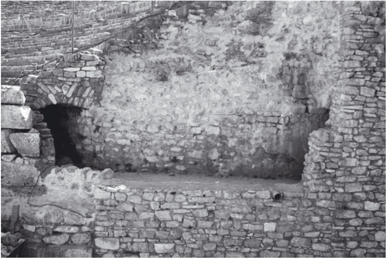
Abb. 825: Freiliegender Bereich der Wasserleitung am Treffpunkt mit dem vomitorium ES1
