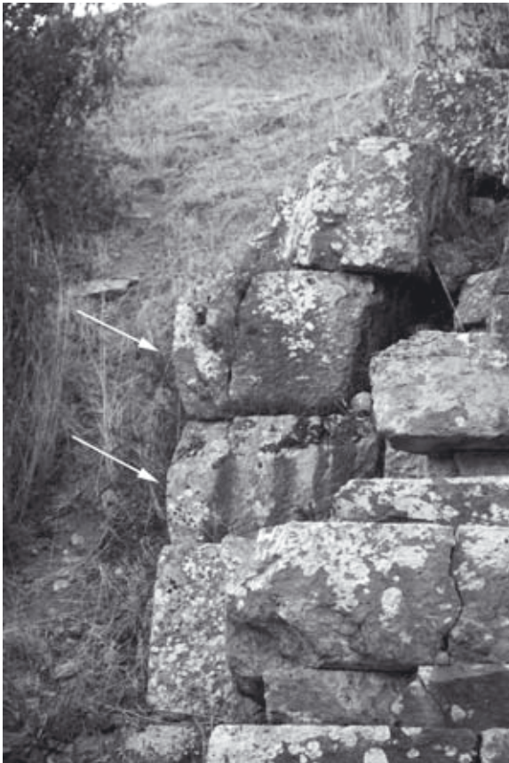
Abb. 793: Nördl. Gebäudeecke des Theaters, von W. In der N-Fassade auch einige Lagen Polsterquader aus grauem Marmor
