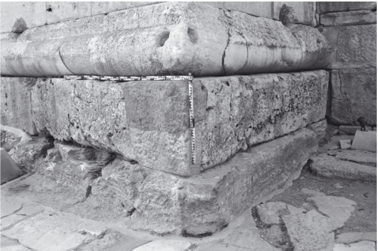
Abb. 819: Süd-Analemma, süd. Gebäudeecke. Nachträglich auf das Niveau der Straße abgearbeitete Fundamentquader (1.)
