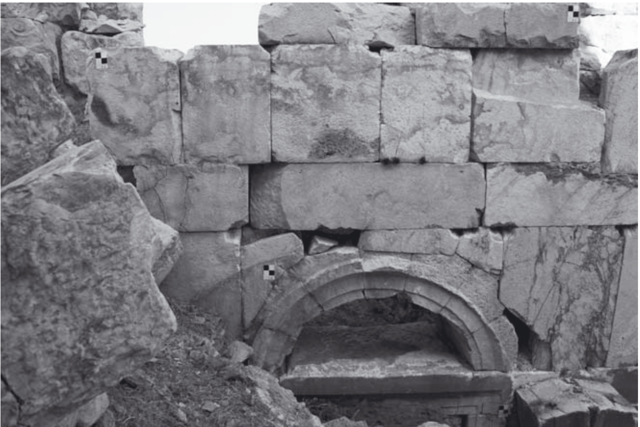
Abb. 841: vomitorium EN1, W-Wand. Teilweise abgearbeitete Tür- u. Oberlichtgewände der Kammereingänge für Pfeilerarkaden
