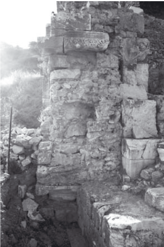
Abb. 844: Nord-Fassade. Weiße Quader (l.) kaiserzeitl. Bauvolumen, die mit Spolien verkleidete Wandschale aus dem 4. Jh. n. Chr. (r.). An den Negativ-Abdrücken im opus caementitium -Kern dieser sekundären Fassade ist sichtbar, dass diese bereits gegen ein vorhandenes Bauvolumen errichtet wurde (Bildmitte)
