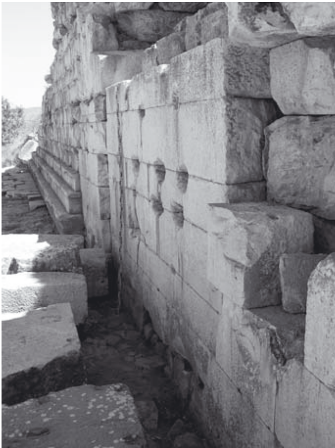
Abb. 797: Nord-Analemma, Blick vom mittleren Fassadenabschnitt nach N. Anschluss der vorgesetzten Terrasse an die Fassade
