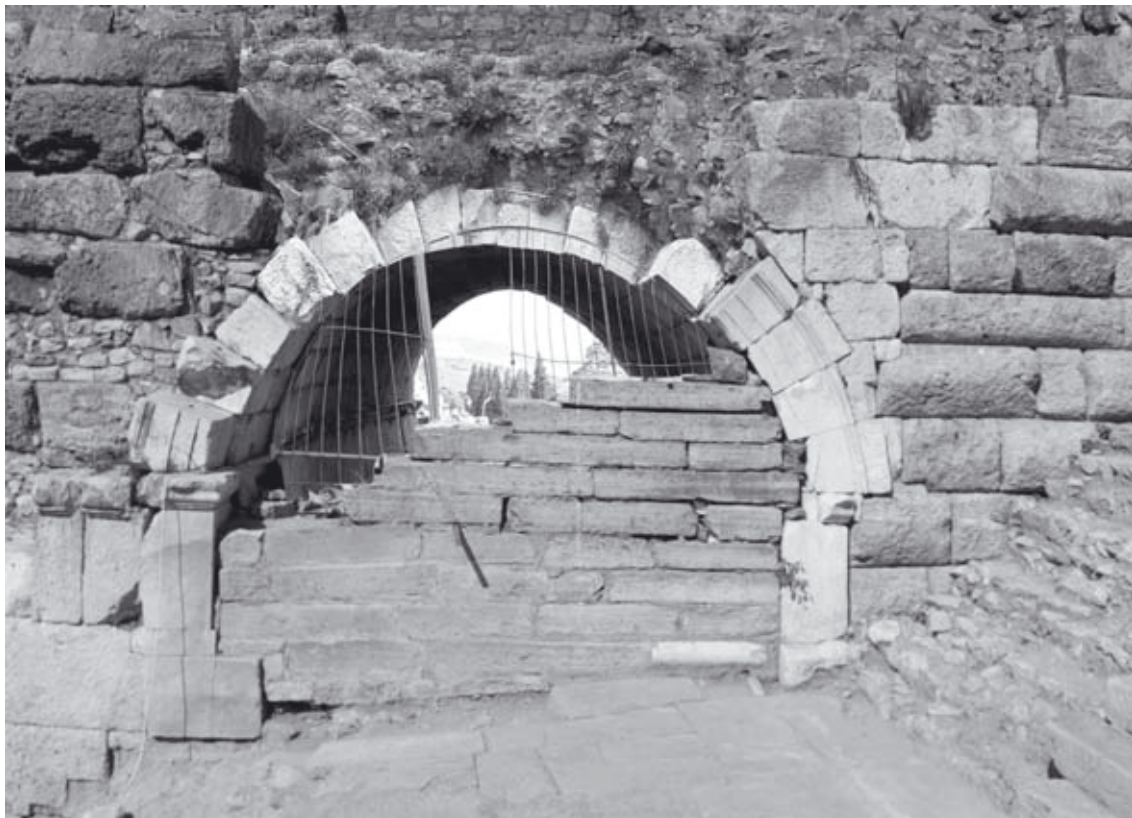
Abb. 847: vomitorium ES2, Verschlusswand, Blick von S.
