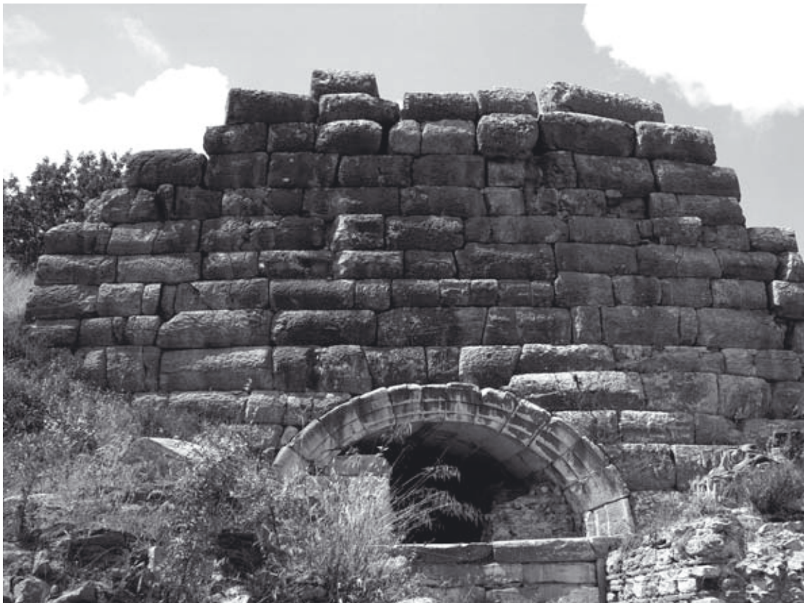
Abb. 767: Oberer Abschnitt der nördl. Außenwand, Polsterquaderfassade aus grauen Marmorquadern
