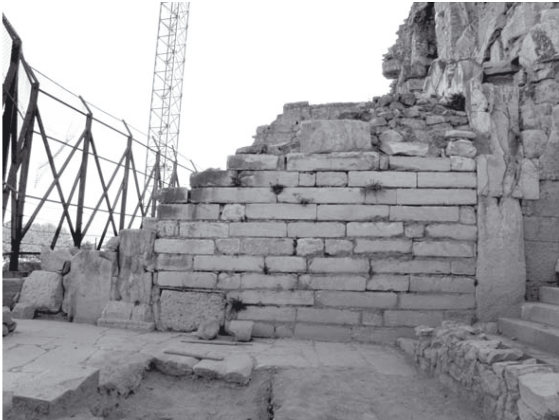
Abb. 846: vomitorium ES1, Verschlusswand, Blick von S.
