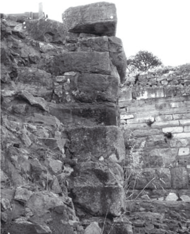
Abb. 806: S-Fassade zwischen den Zugängen ES2 u. ES3 mit zusätzlicher innerer Wandschale aus opus caementitium
