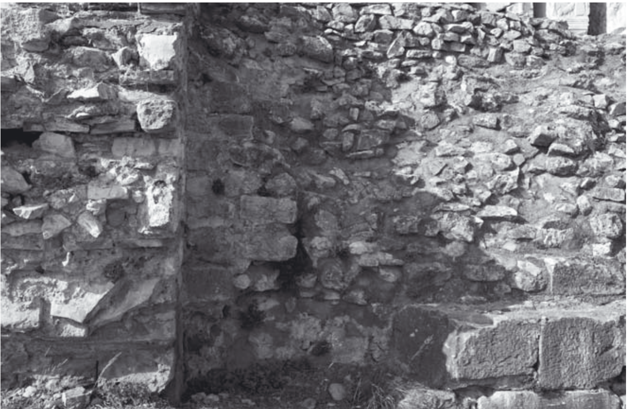
Abb. 843: Nord-Fassade. Eckverbindung aus Bruchstein der orthogonal zur Außenwand errichteter Strebemauer (l.) u. der vorgelagerten Wandschale (r.) aus weißen Marmorspolien mit opus caementitium -Kern (vgl. Abb. 831)
