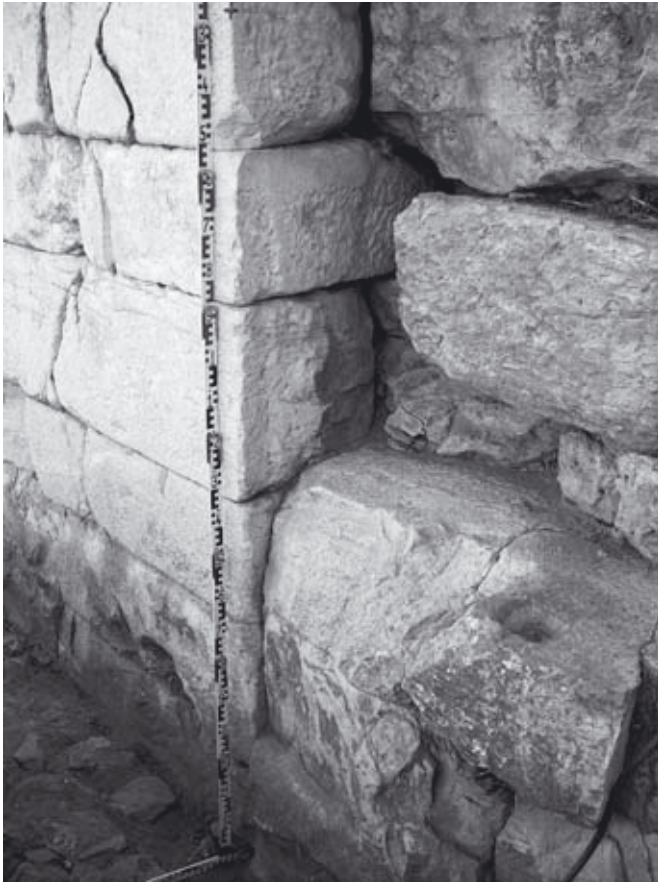
Abb. 796: Nord-Analemma, mittlerer Fassadenabschnitt. Kontaktstelle von Bogenpfeiler (r.) u. Bogenfüllung (l.)
